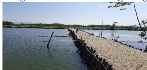
Hình 6. Đập tạm Tứ Câu
