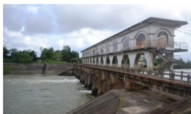
Hình 2. Đập dâng An Trạch
