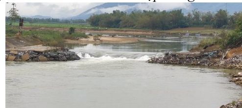
Hình 6. Đập tạm Quảng Huế
