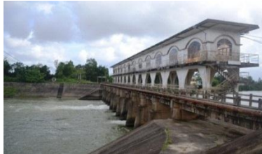
Hình 2. Đập dâng An Trạch
