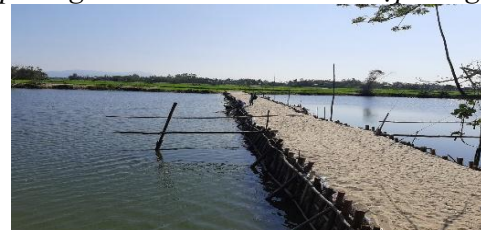
Hình 6. Đập tạm Tứ Câu
