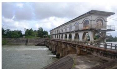
Hình 2. Đập dâng An Trạch
