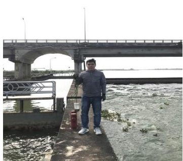
Hình 4. Đập Thảo Long
