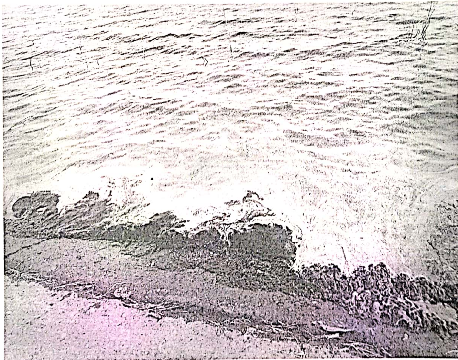
Hình 1: Chất lạ tại K0+700 đập Tây hồ Đại Lải
