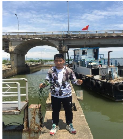
Hình 5. Đập Thảo Long
