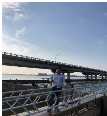
Hình 1. Đập Thảo Long
