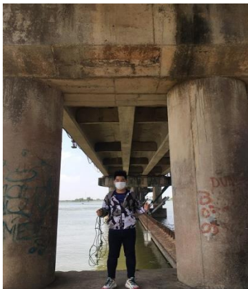
Hình 4. Đập Thảo Long
