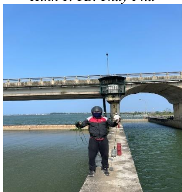
Hình 4. Đập Thảo Long
